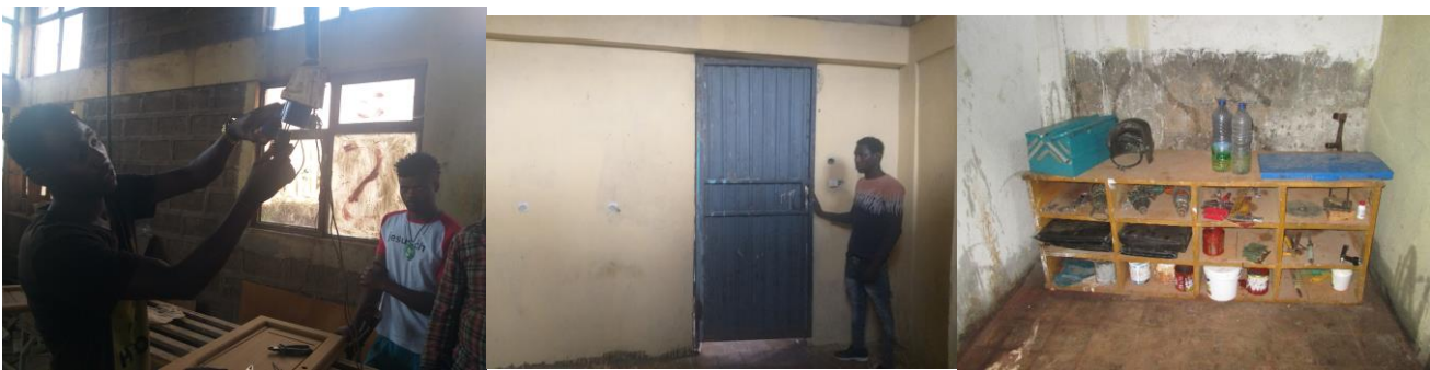
SCH Elektriker Temesgegn «in action» - frisch gestrichen 😊 - und «schweizerisch aufgeräumt 😊»!
